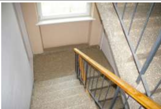
Dzīvojamā ēka ar kadastra apzīmējumu 1700 031 0081 001, koplietošanas telpa
